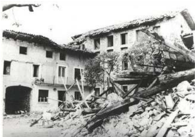
1976 Terremoto del Friuli
